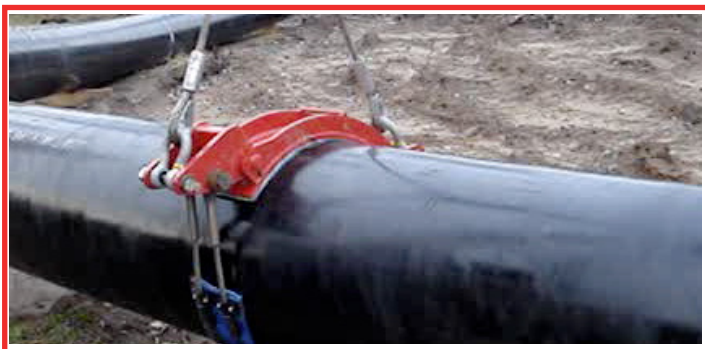
Choker Belts worden gebruikt bij het plaatsen en buigen van pijpleidingen.
